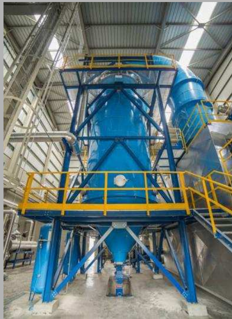
Λεβητοστάσιο διαθερμικού ελαίου
