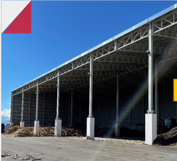
Υπόστεγο Αποθήκευσης Καυσίμου
